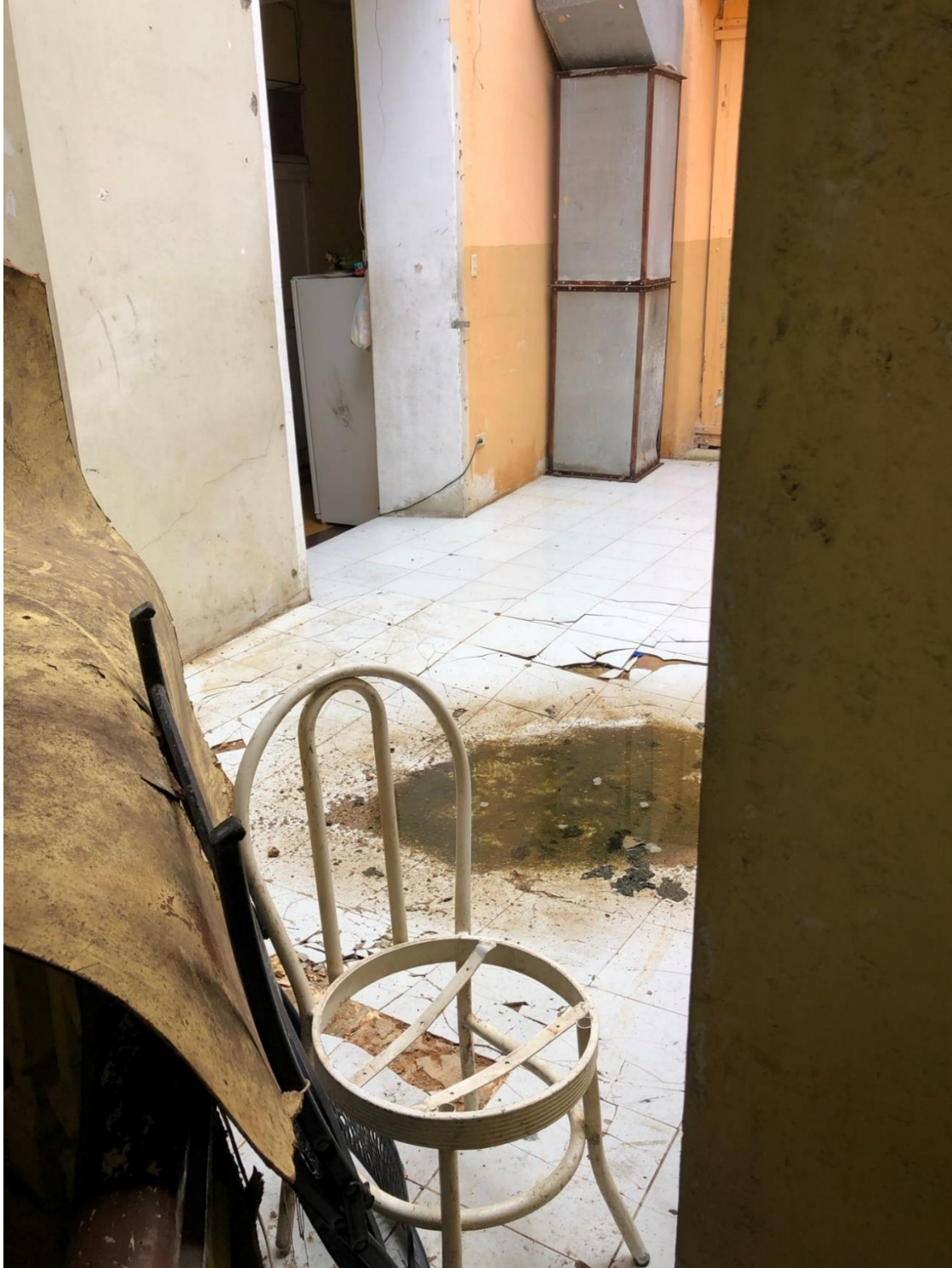
IMAGEN 5. LOSA HUNDIDA
