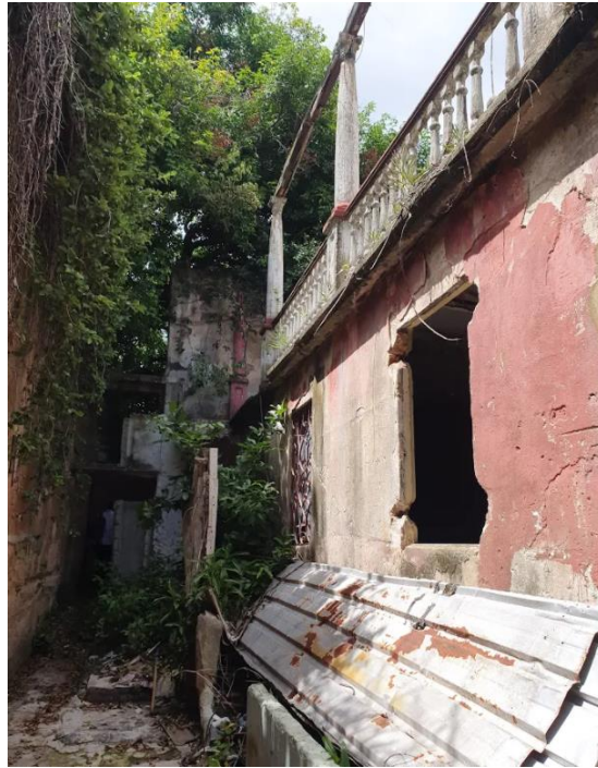
IMAGEN 2. VISTA DEL INTERIOR DE LA EDIFICACIÓN (ACCESO AL PATIO)
