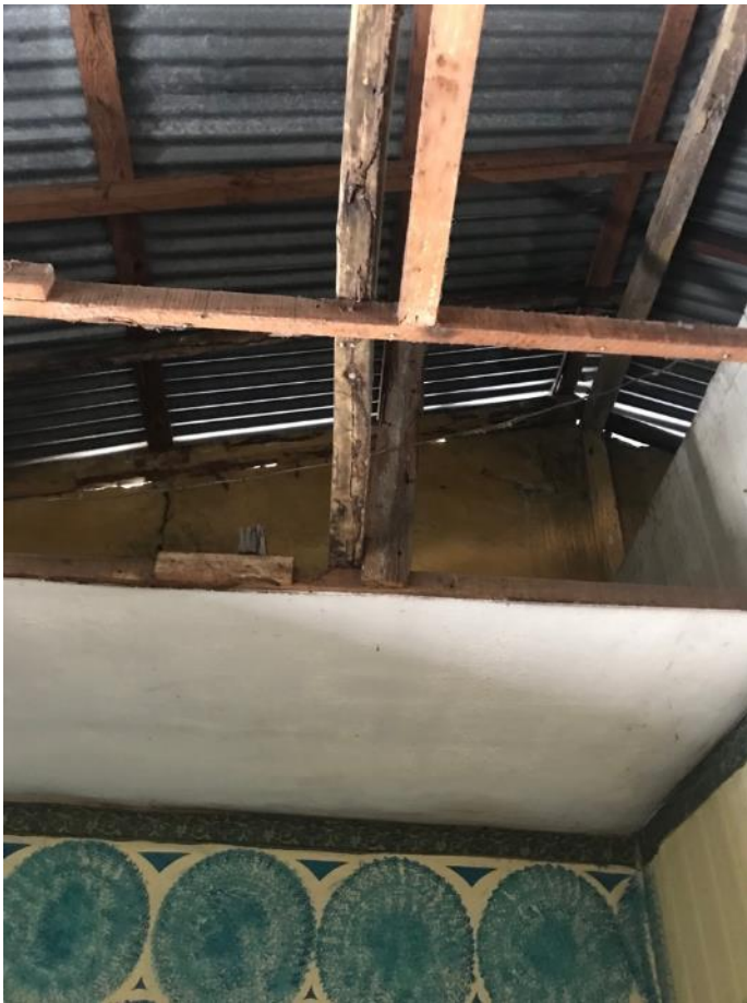
IMAGEN 4. CUBIERTA INFERIOR DE TECHO DESPRENDIDA
