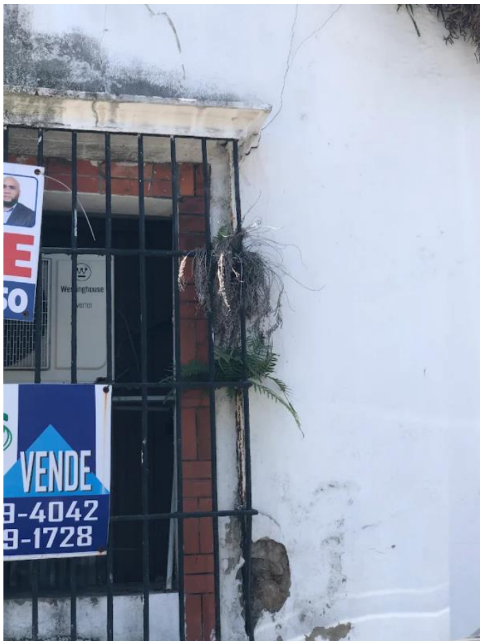
IMAGEN 2. GRIETAS EN MUROS DE MAMPOSTERIA EN PARTE EXTERIOR Y ENTRADA DEL EDIFICIO.
