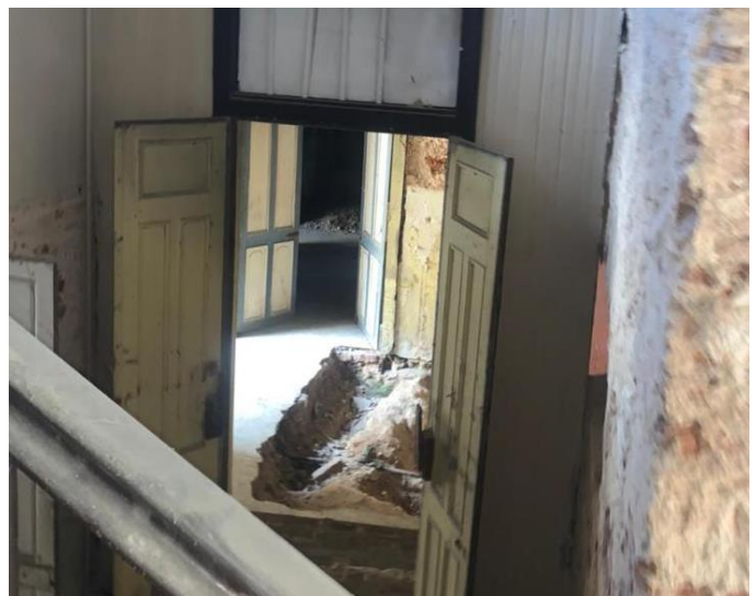
IMAGEN 3. EXCAVACIONES Y AGUJERO
