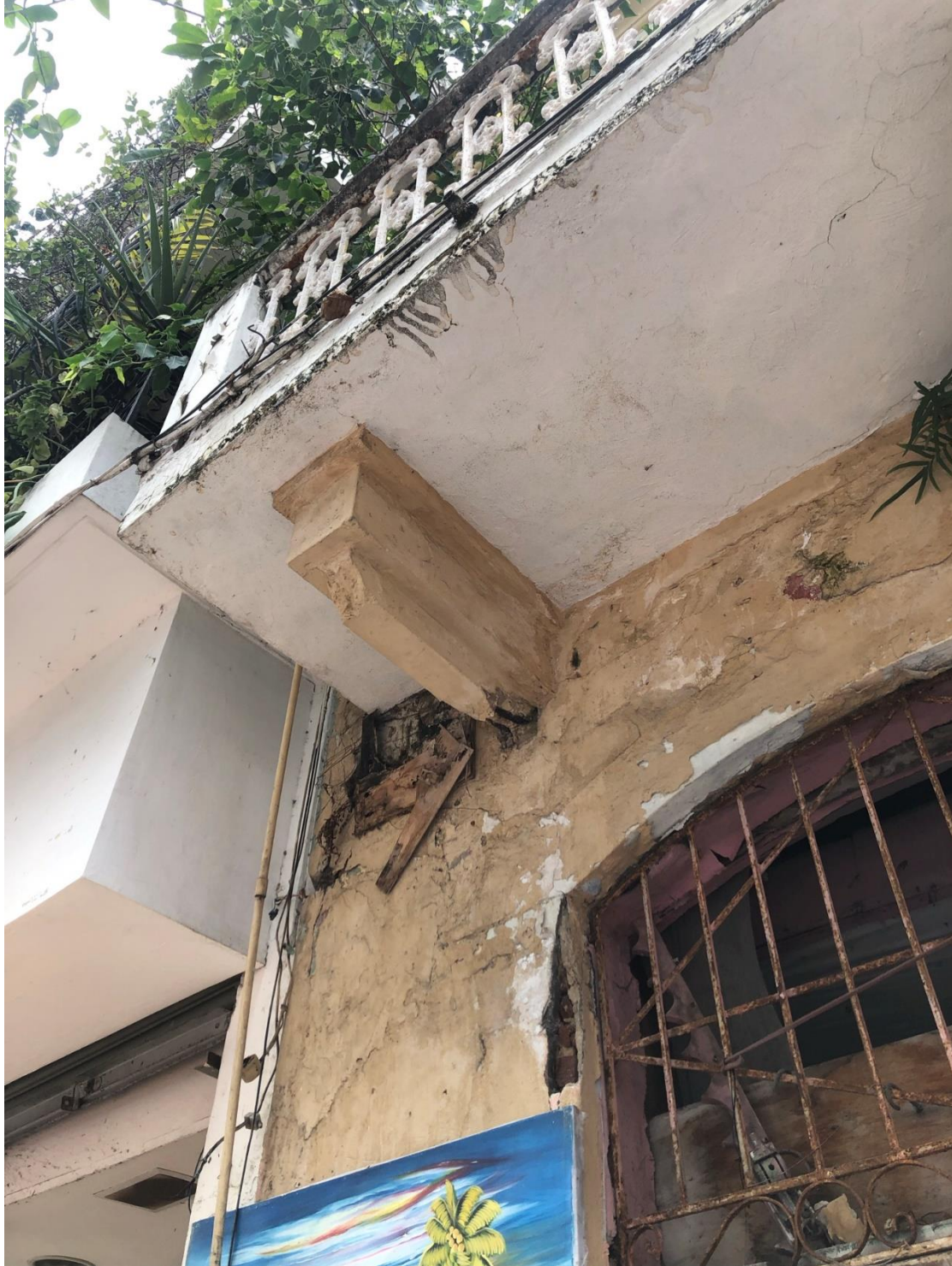
IMAGEN 5. AMPLIACIÓN EN MAMPOSTERÍA DE BLOQUES DE CONCRETO
