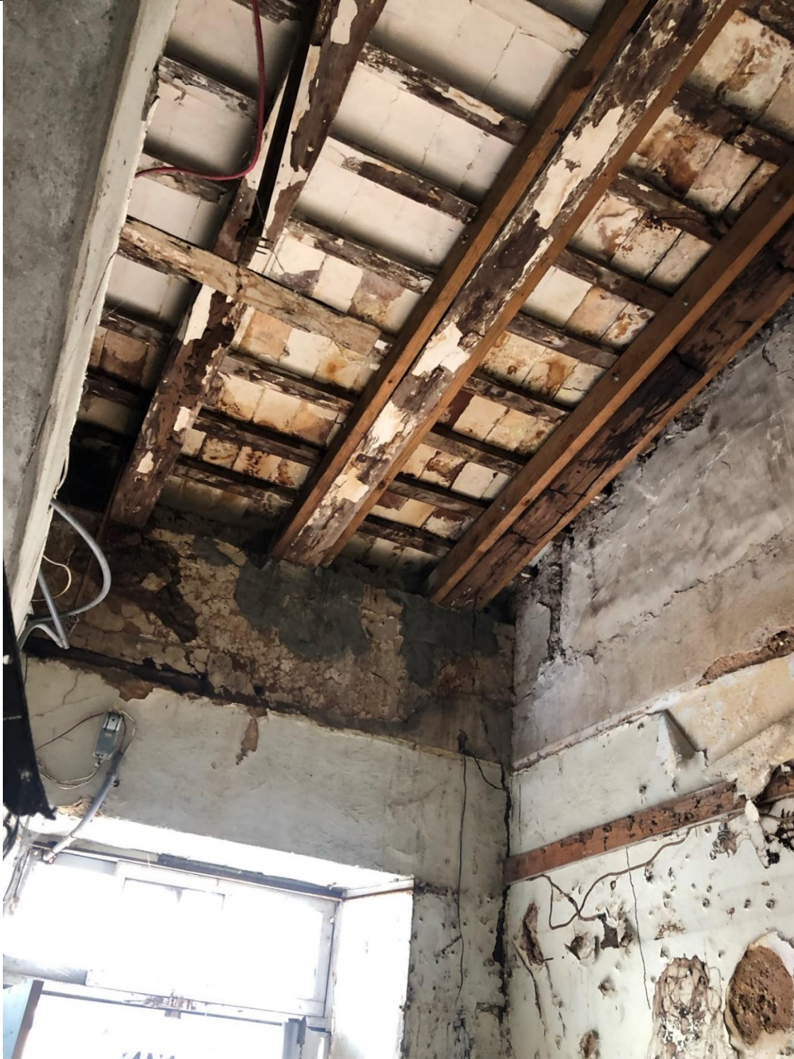
IMAGEN 5. GRIETAS EN EL DINTEL DE ENTRADA A LA EDIFICACION
