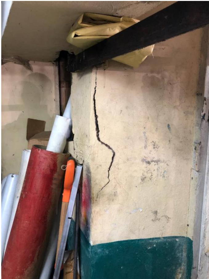
IMAGEN 4. GRIETAS EN COLUMNAS (PARTE INTERIOR DEL EDIFICIO).
