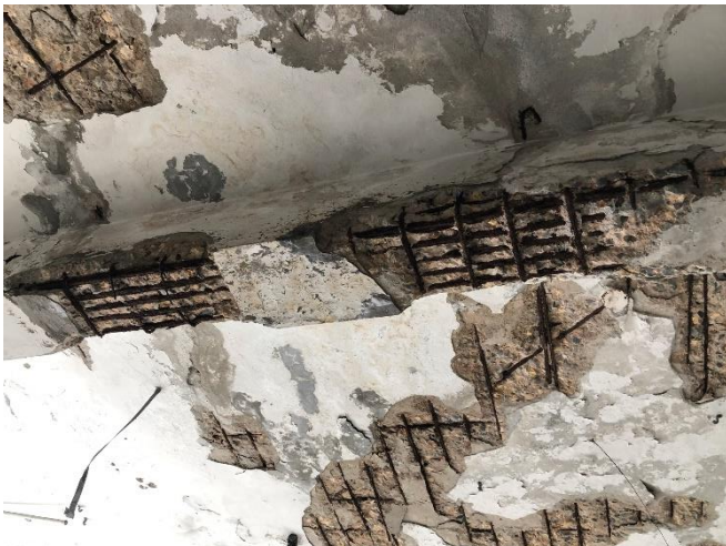
IMAGEN 5. GRIETAS Y CORRISION DEL ACERO EN VIGAS Y COLUMNAS DE CONCRETO ARMADO
