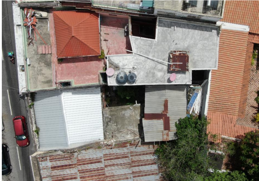
IMAGEN 2. VISTA DE TECHOS TOMADA POR DRONE
