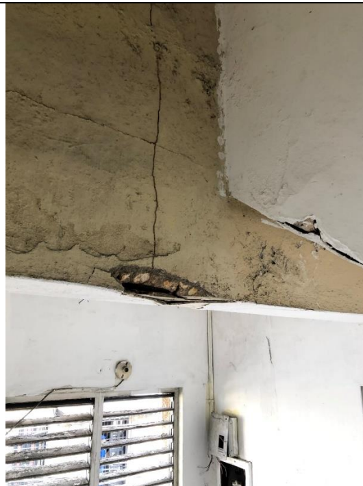
IMAGEN 6. AMPLIACIÓN EN MAMPOSTERÍA DE BLOQUES DE CONCRETO
