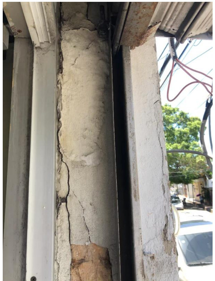
IMAGEN 2. GRIETAS EN MUROS DE MAMPOSTERIA EN PARTE EXTERIOR Y ENTRADA DEL EDIFICIO.
