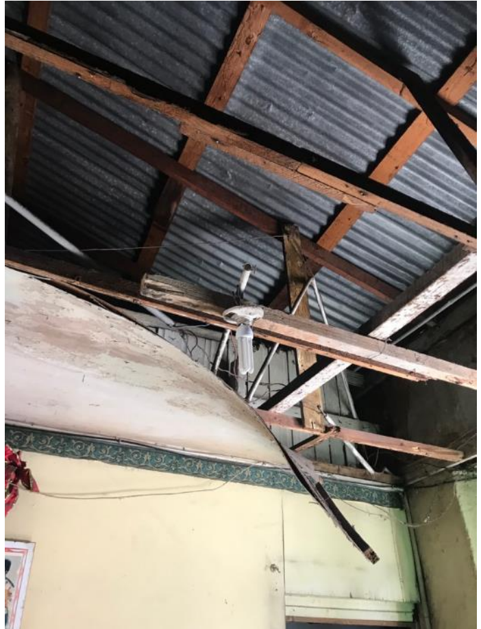
IMAGEN 4. CUBIERTA INFERIOR DE TECHO DESPRENDIDA
