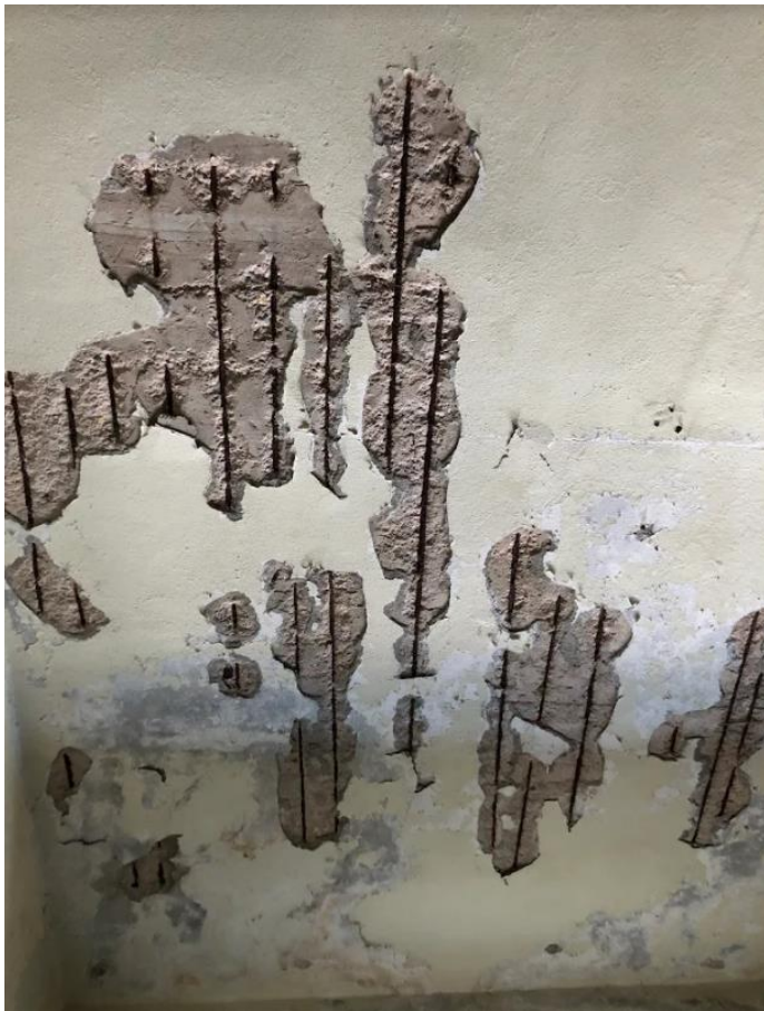
IMAGEN 2. DESPRENDIMIENTO DEL RECUBRIMIENTO DEL TECHO Y CORROSIÓN EN EL ACERO.
