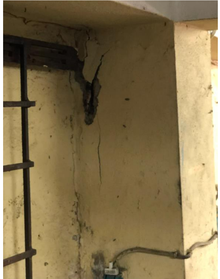
IMAGEN 4. GRIETAS EN COLUMNAS (PARTE INTERIOR DEL EDIFICIO).
