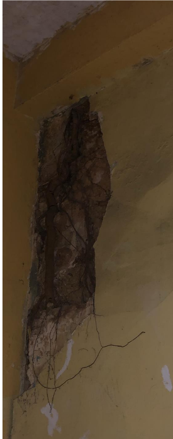
IMAGEN 4. PLANTAS PARASITAS EN LOS MUROS.
