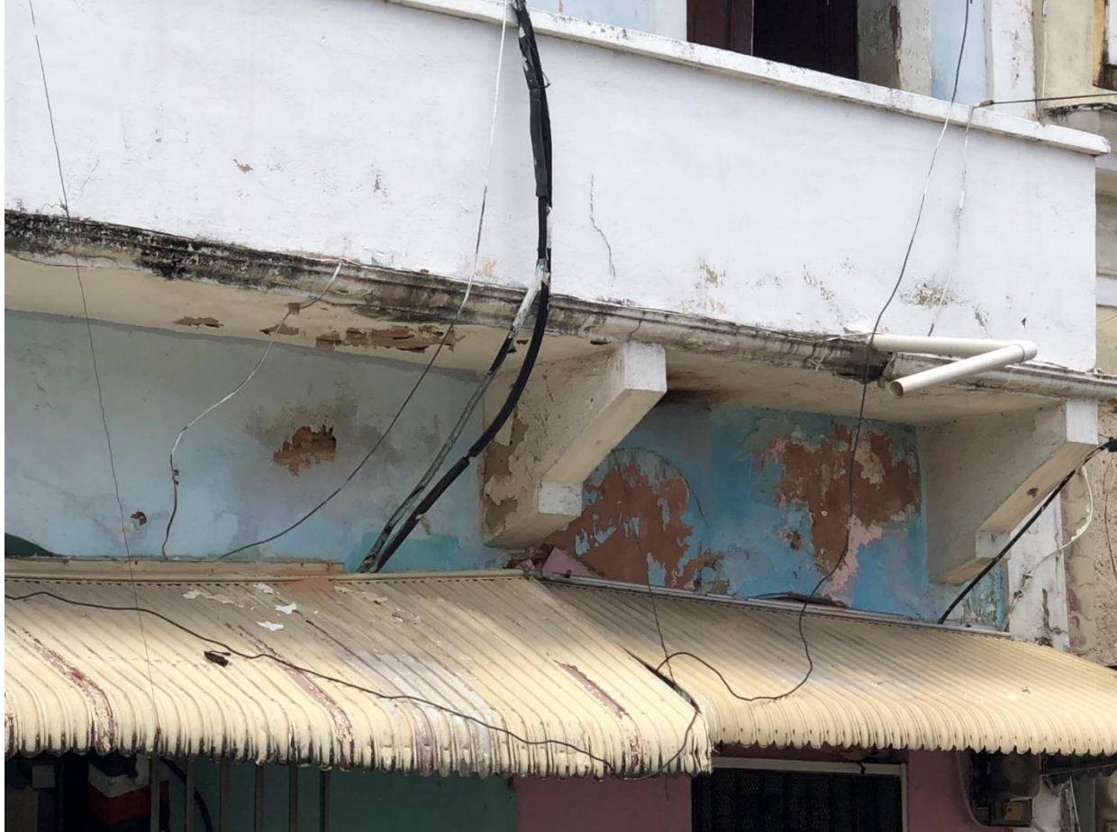
IMAGEN 5. AMPLIACIÓN EN MAMPOSTERÍA DE BLOQUES DE CONCRETO
