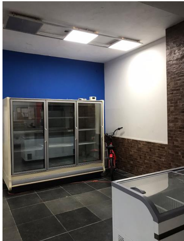
IMAGEN 3. ESTRUCTURA DE LA PARTE INTERIOR DE LA EDIFICACIÓN (PRIMER NIVEL, COMERCIO)
