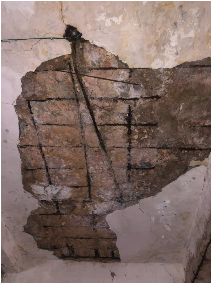
IMAGEN 4. DESPRENDIMIENTO DEL RECUBRIMIENTO DEL TECHO Y CORROSIÓN EN EL ACERO.
