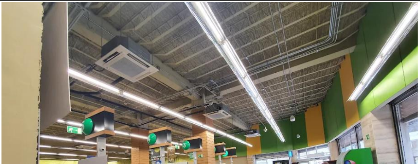
IMAGEN 3. ESTRUCTURA DE LA PARTE INTERIOR DE LA EDIFICACIÓN
