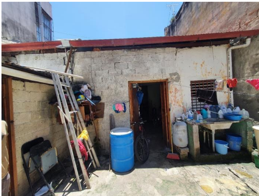
IMAGEN 7. AMPLIACIÓN EN MAMPOSTERÍA DE BLOQUES DE CONCRETO
