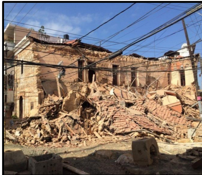
Ilustración 2. Derrumbe parte frontal Hotel Francés en mayo del 2015
