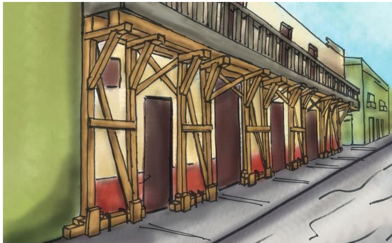
IMAGEN 8. EJEMPLO DE APUNTALAMIENTO DE LA FACHADA
