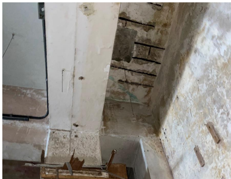
IMAGEN 2. DEPENDRIMIENTO DE RECUBRIMIENTO
