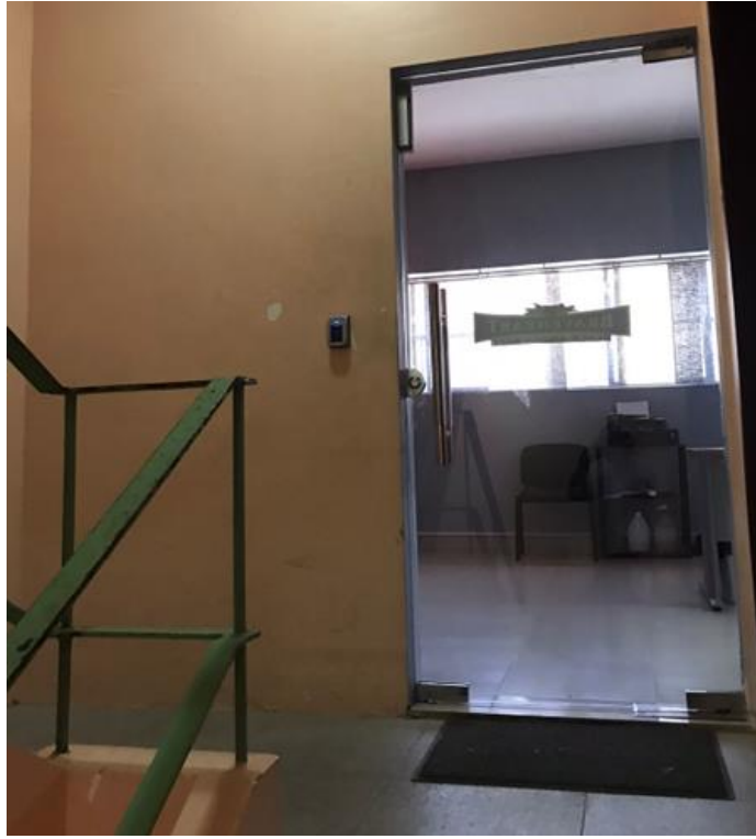
IMAGEN 4. ESTRUCTURA DE LA PARTE INTERIOR DE LA EDIFICACIÓN (SEGUNDO NIVEL, OFICINAS)
