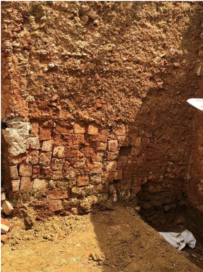
IMAGEN 2. MUROS DE TAPIA AL DESCUBIERTO Y SIN TECHO
