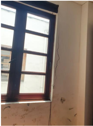
IMAGEN 4. GRIETAS CERCA DE LAS VANTANAS EN MUROS DE MAMPOSTERIA DE BLOQUES DE LA EDIFICACIÓN
