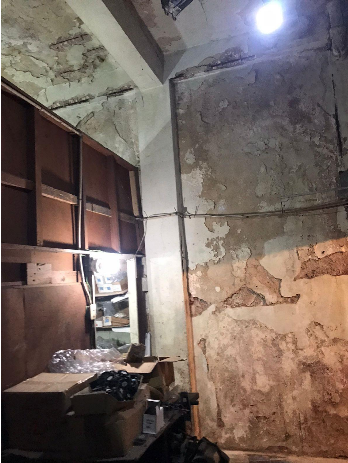
IMAGEN 4. BARRAS DE REFUERZO EXPUESTAS AL AIRE LIBRE.
