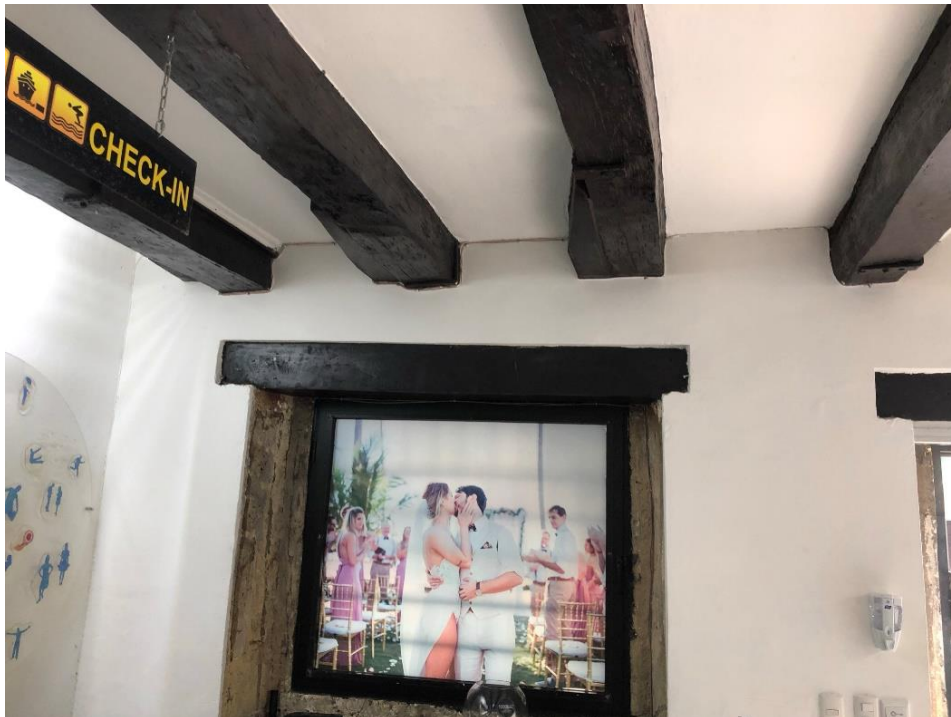
IMAGEN 5. VISTA DEL TECHO EN MADERA
