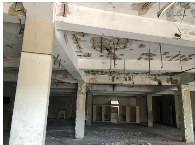
IMAGEN 3. LOSAS DE CONCRETO CON RECUBRIMIENTO DESPRENDIDO Y ACERO DE REFUERZO EXPUESTO
