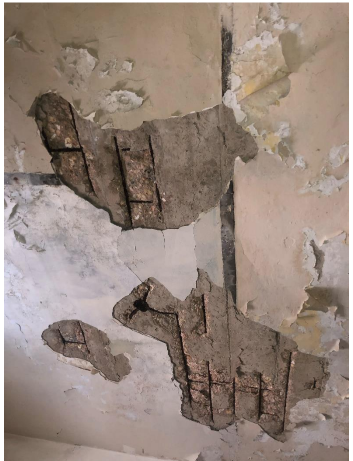
IMAGEN 4. DESPRENDIMIENTO DEL RECUBRIMIENTO DEL TECHO Y CORROSIÓN EN EL ACERO.
