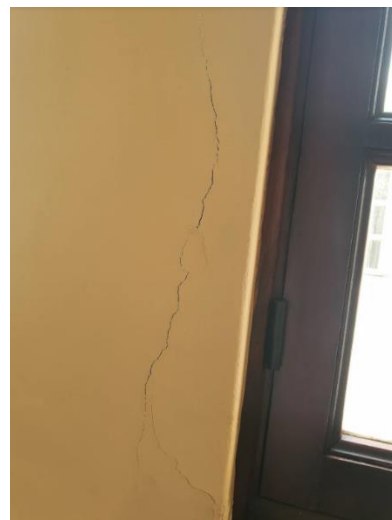
IMAGEN 4. GRIETAS CERCA DE LAS VANTANAS EN MUROS DE MAMPOSTERIA DE BLOQUES DE LA EDIFICACIÓN
