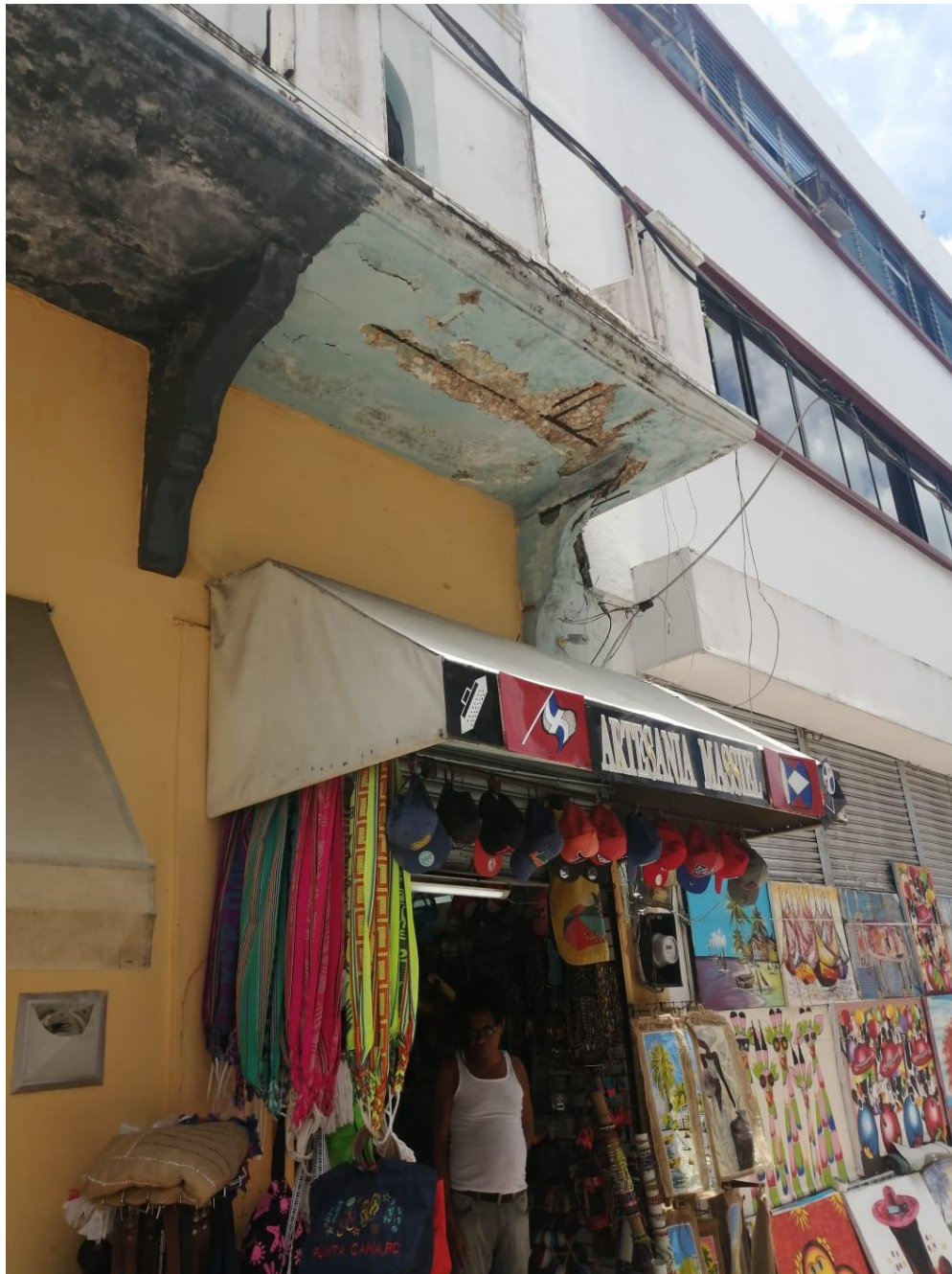
IMAGEN 2. PARTE INFERIOR DE LOS BALCONES
