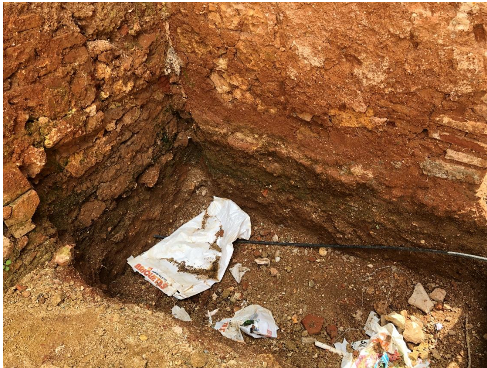
IMAGEN 3. CALICATAS REALIZADAS EN LA EDIFICACIÓN
