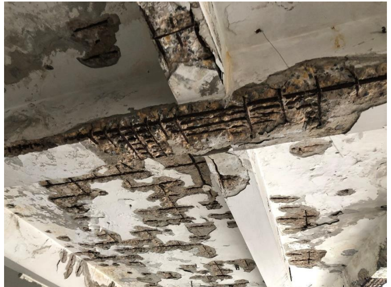
IMAGEN 5. GRIETAS Y CORRISION DEL ACERO EN VIGAS Y COLUMNAS DE CONCRETO ARMADO
