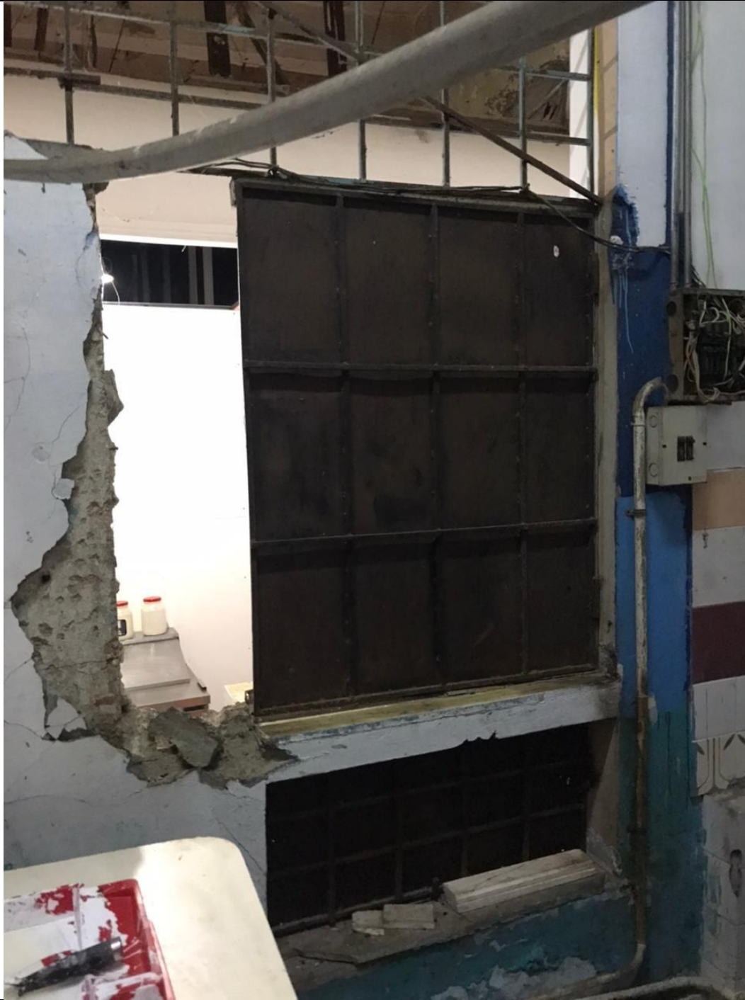
IMAGEN 5. MODIFICAICONES NO INGENIERILES A LA ESTRUCTURA.
