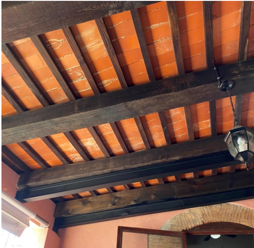
IMAGEN 5. PARTE REFORZADA DEL TECHO
