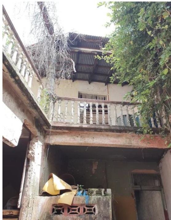
IMAGEN 3. VISTA DEL INTERIOR (BALCÓN)
