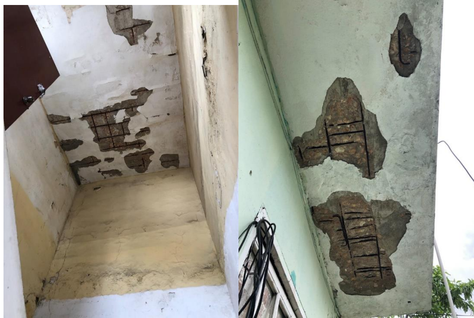
IMAGEN 5. GRIETAS EN EL DINTEL DE ENTRADA A LA EDIFICACION
