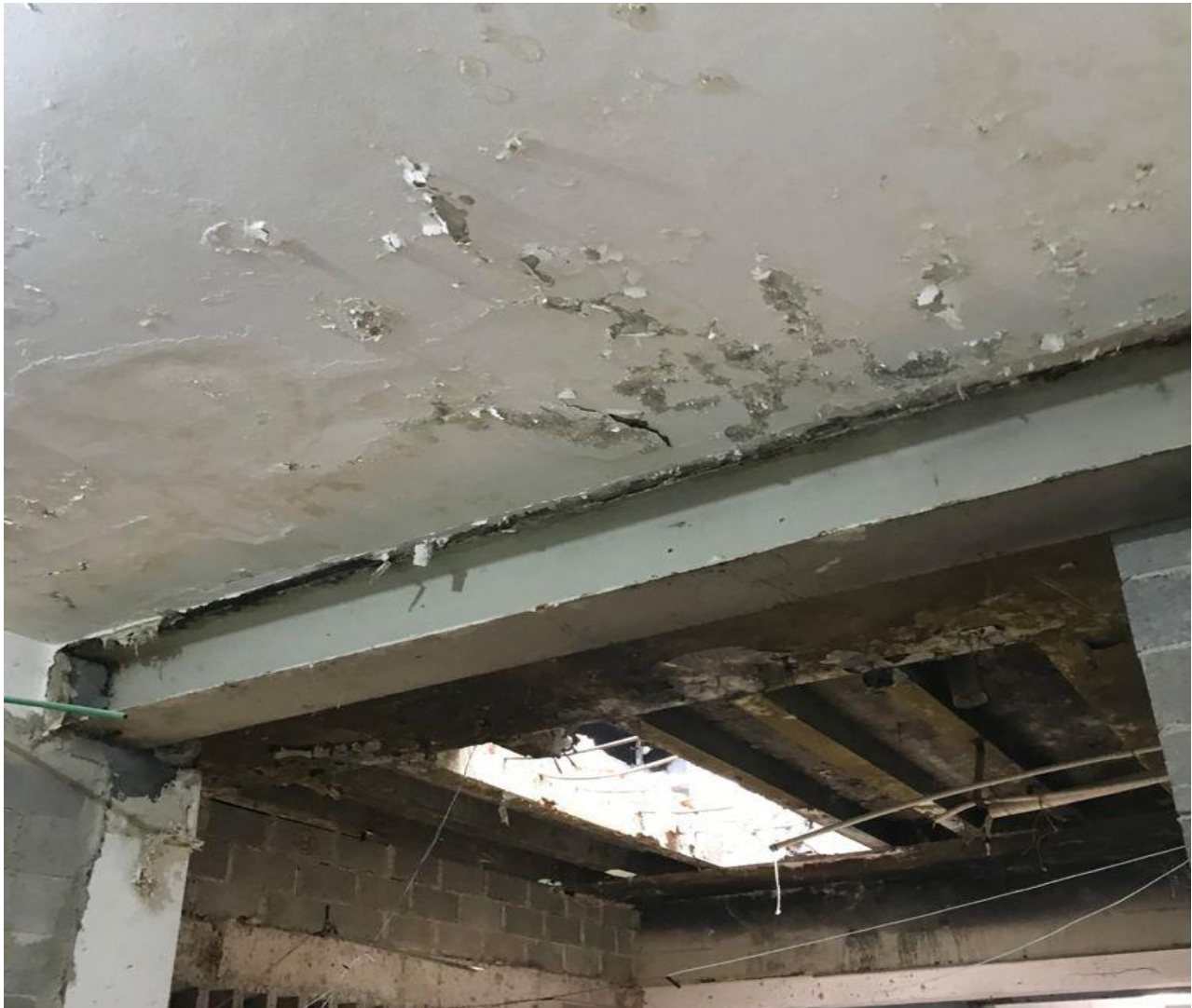
IMAGÉN 2. VIGA METÁLICA
