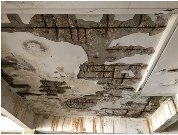
IMAGEN 3. LOSAS DE CONCRETO CON RECUBRIMIENTO DESPRENDIDO Y ACERO DE REFUERZO EXPUESTO
