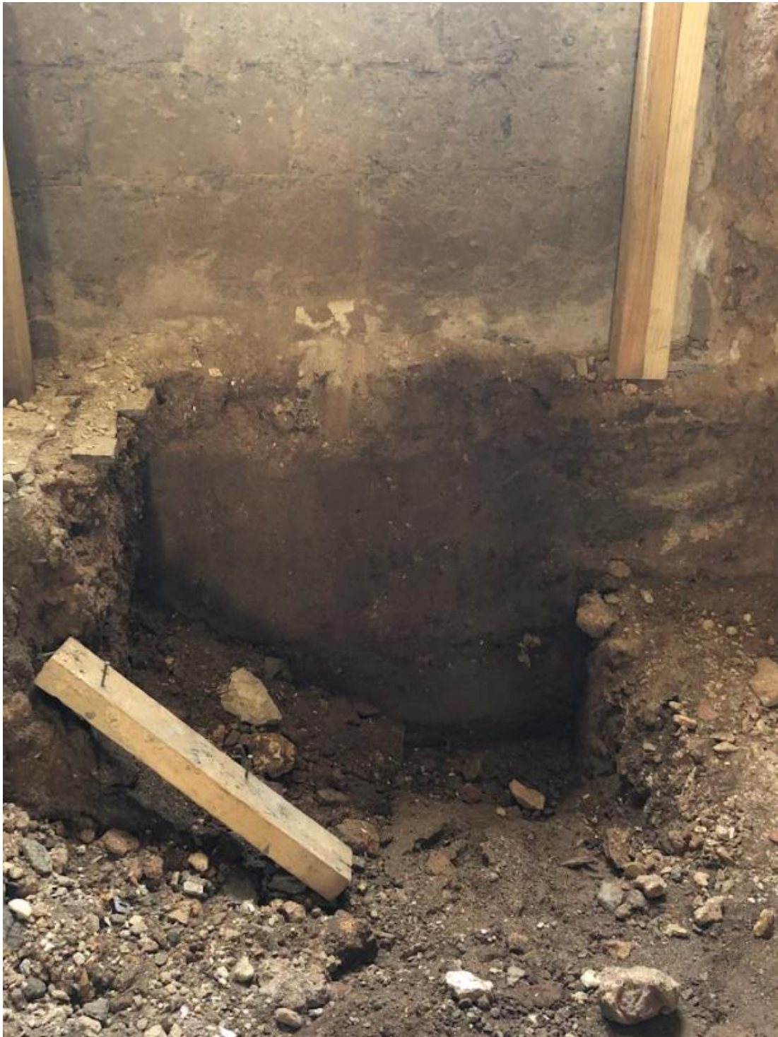
IMAGEN 3. CALICATAS REALIZADAS EN LA EDIFICACIÓN
