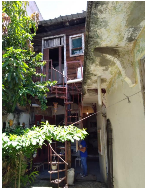
IMAGEN 3. VISTA INTERIOR DE ANEXO
