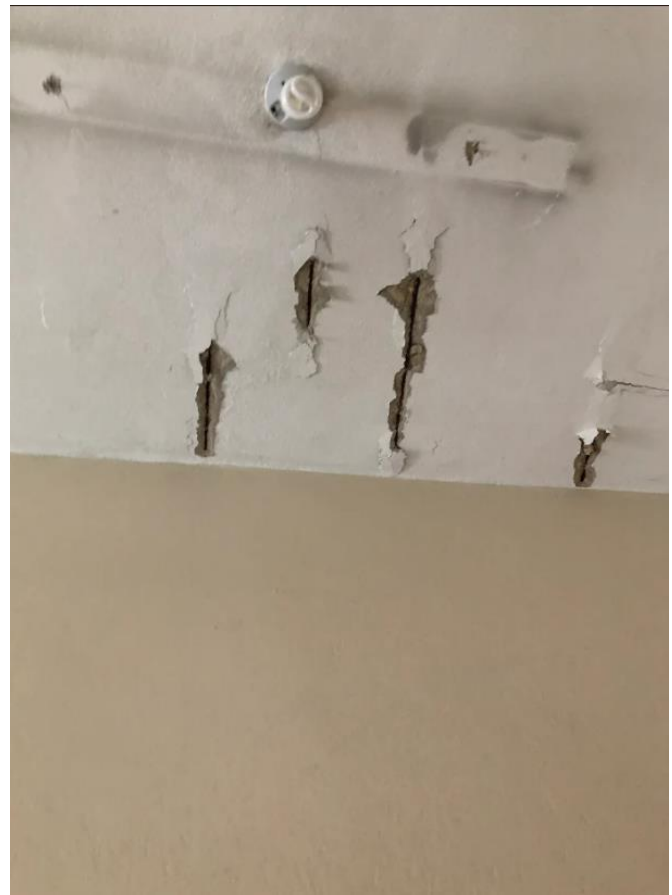
IMAGEN 2. DESPRENDIMIENTO DEL RECUBRIMIENTO DEL TECHO Y CORROSIÓN EN EL ACERO.
