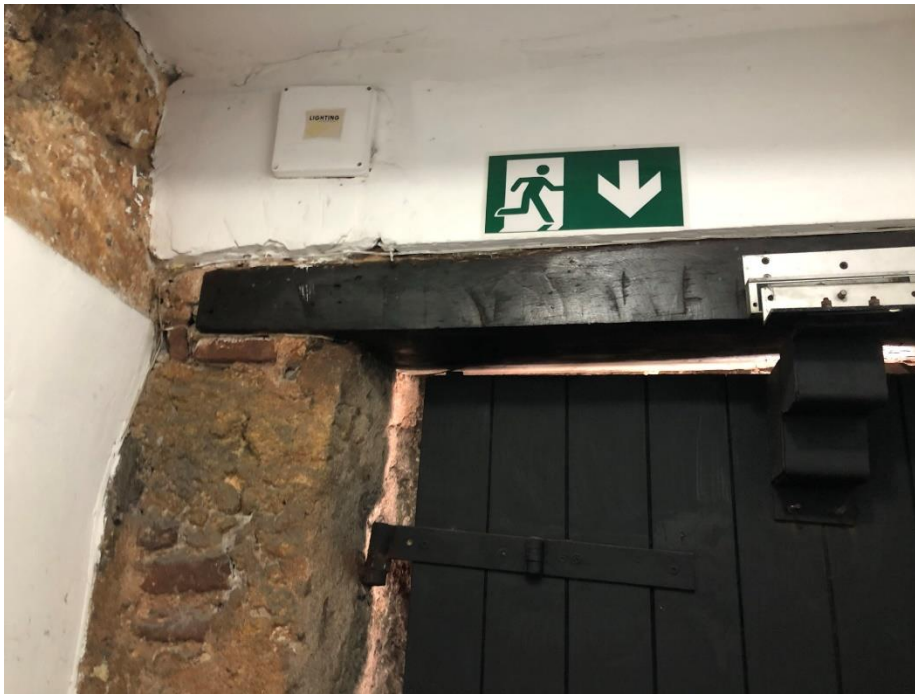
IMAGEN 4. DINTELES DE MADERA EN LOS MUROS
